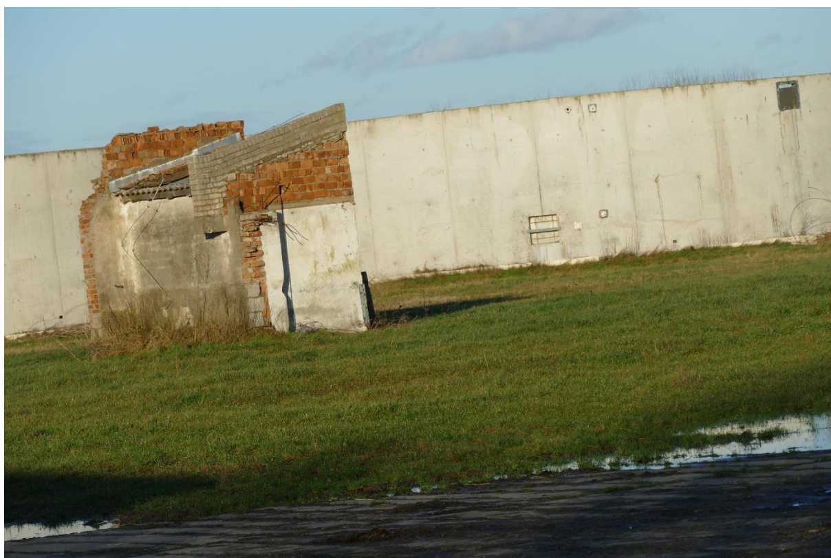
Bild 03 offenes Gebäude im Norden
